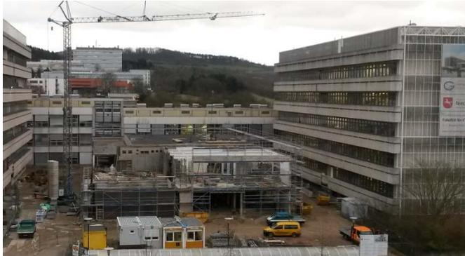
Zurzeit laufen die Rohbauarbeiten und manch interessierter Beobachter wird sich fragen, warum die Arbeiten so schleppend vorangehen. Der Grund für den Ablauf der Arbeiten ist die Statik. Bevor eine Wand oder Decke entfernt wird, muss sichergestellt werden, dass durch dann fehlende Scheibenwirkung an anderer Stelle Schäden auftreten. Wir müssen also zunächst den neuen Hörsaal fertigstellen um das Dach der anderen beiden Hörsäle zu ersetzen. Das gilt für alle, statisch wirksamen Bauteile.
